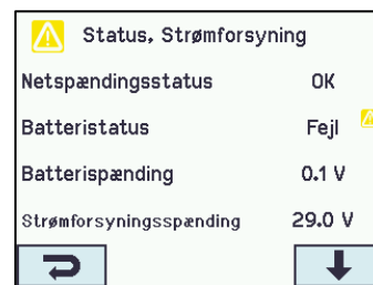
Fejl på Batteristatus
